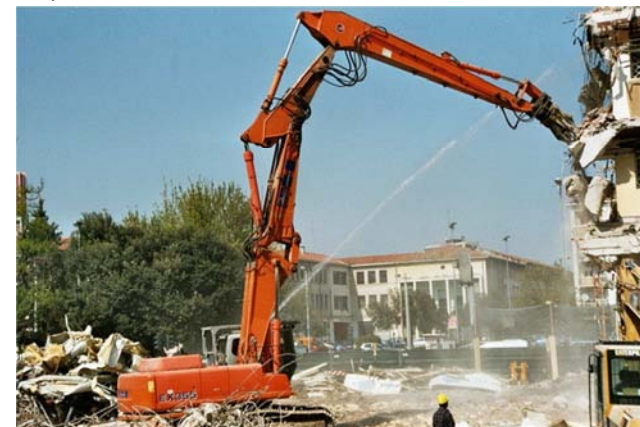
Demolizione Standa - 2006 - Pordenone
