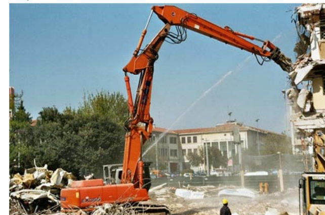
Demolizione Standa - 2006 - Pordenone
